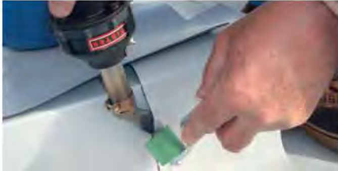
HOT JET S sa ugaonom diznom prilikom zavarivanja T spoja na krovu
