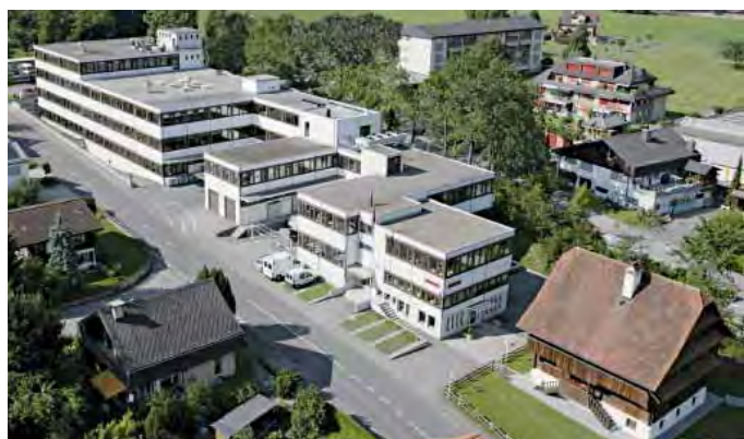
Leister Technologies AG, zgrada fabrike, Kaegiswil, Švajcarska
