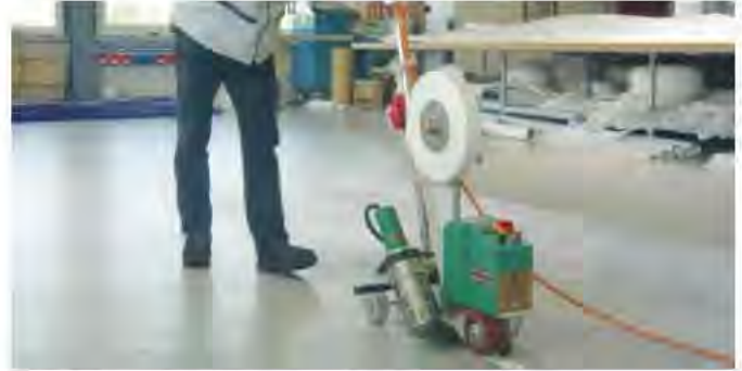
Zavarivanje trake maksimalnom brzinom.
