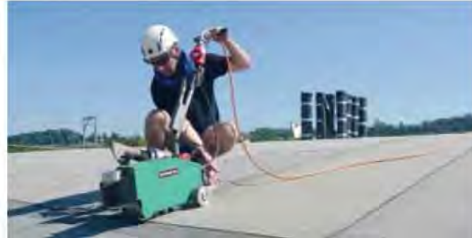
Zavarivanje modifikovanog bitumena korišćenjem BITUMAT B2.
