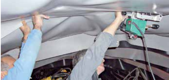
Comet prilikom upotrebe u tunelu ...
