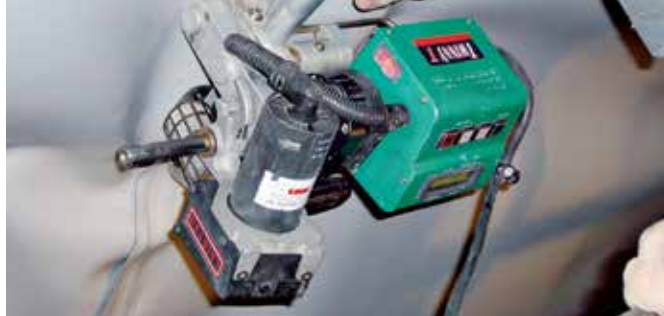
TWINNY T, sa ukrštenom drškom, prilikom izrade tunela.
