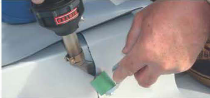
HOT JET S sa ugaonom diznom prilikom zavarivanja T spoja na krovu
