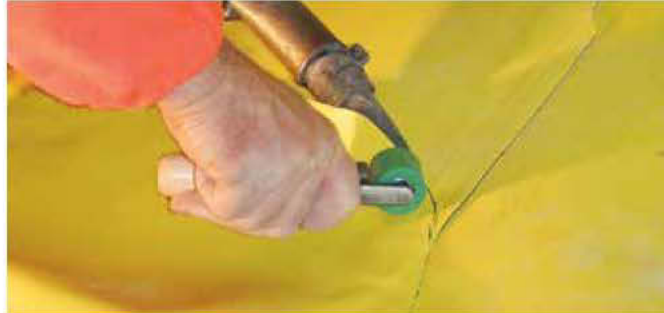
Jednoručni valjak predstavlja obaveznu opremu pri izradi tunela
