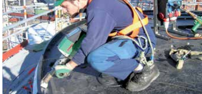
WELDPLAST S4 na gradilištu u Španiji..
