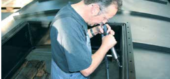
Zavarivanje PE kontejnera upotrebom DIODE PID.
