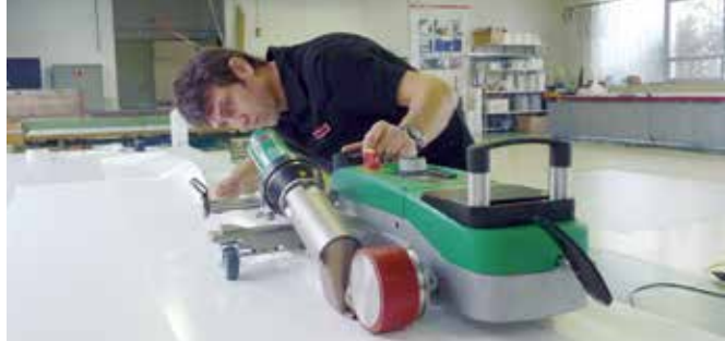
Lako zavarivanje cevi i krivina.
